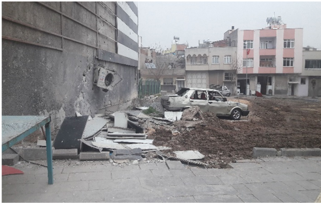
Resim 1: 2018 Zeytindalı Operasyonu sırasında Kiliş'e düşen roketin yarattığı yıkım
