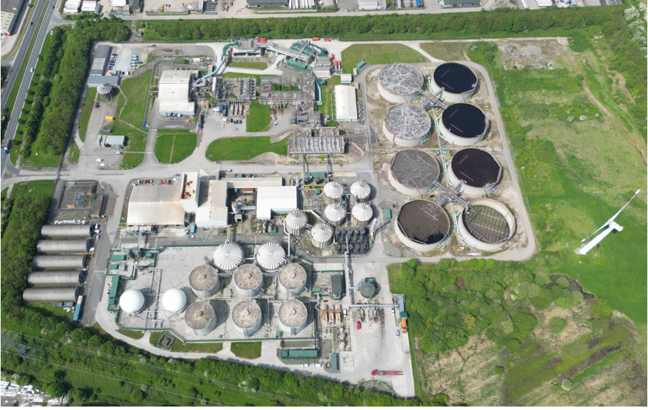
Şekil 16.7 Atık su arıtma tesisinin genel görüntüsü.
