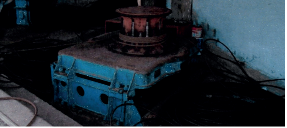
Şekil 8. Teknelerin karaya çekilmesinde kullanılan vinç ve çelik halatlar
