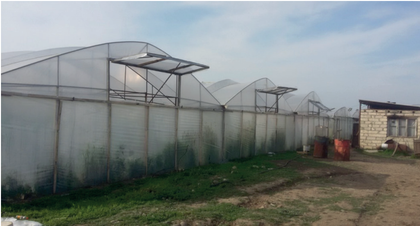
Resim 4. Alın duvarındaki havalandırma pencerelerinin konumu.
