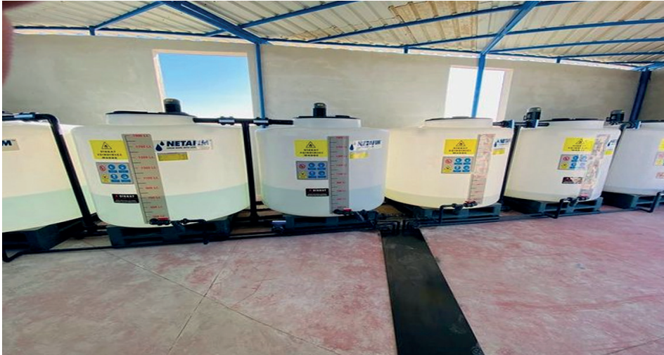
Şekil 26. Sulama odasında kullanılan gübre tankları örneği
