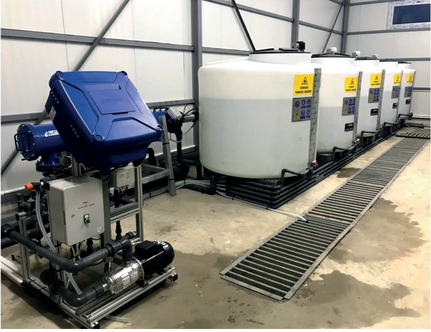
Şekil 31. Yapay zeka sulama kontrolörüne sahip bir sulama otomasyon odası
