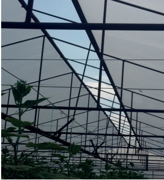
Resim 5. Beşik çatılı bir serada mahya havalandırma açıklığı.
