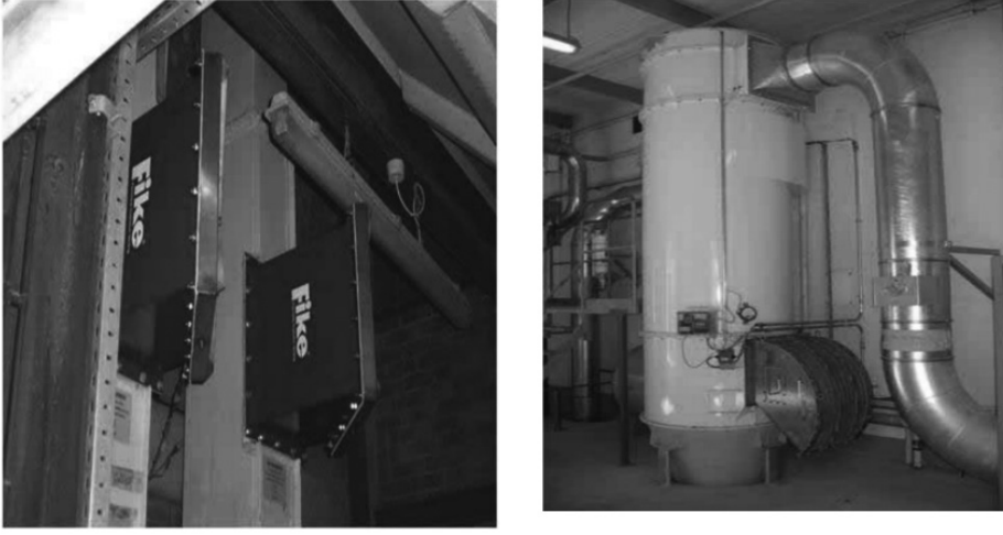
Şekil 6. Alevsiz Patlama Kapakları Uygulama Örnekleri (32)
