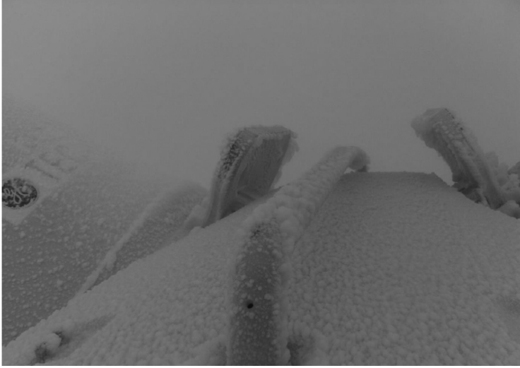
Şekil 8. Nacelle üzerinde meydana gelen buzlanma (18)
