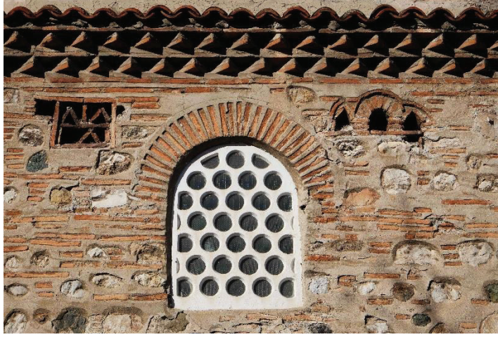
Fot. 36- Taşçılar Mescidi. Güney cephedeki kuş evleri.
