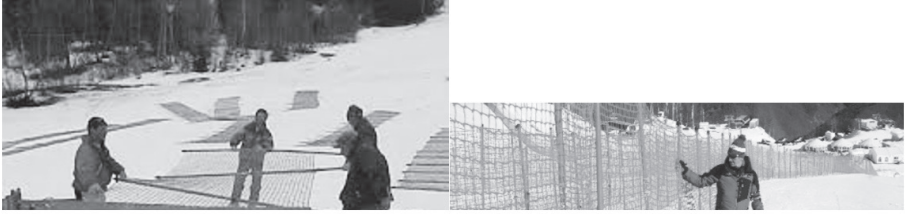
Şekil 13. Ağların (netlerin) yerleştirilmesi ( https://alpinecanada , 2022),( https://www.tesmasport , 2022)
