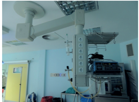
Resim 2: Tavana monte edilmiş depolama alanları.
